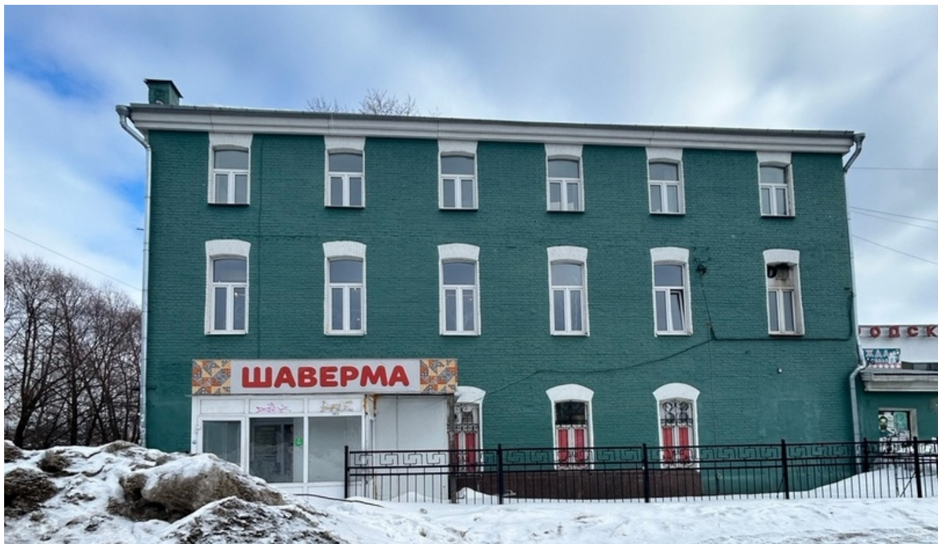
Фотографии фактического состояния фасада с указанием даты (фототаблица)
