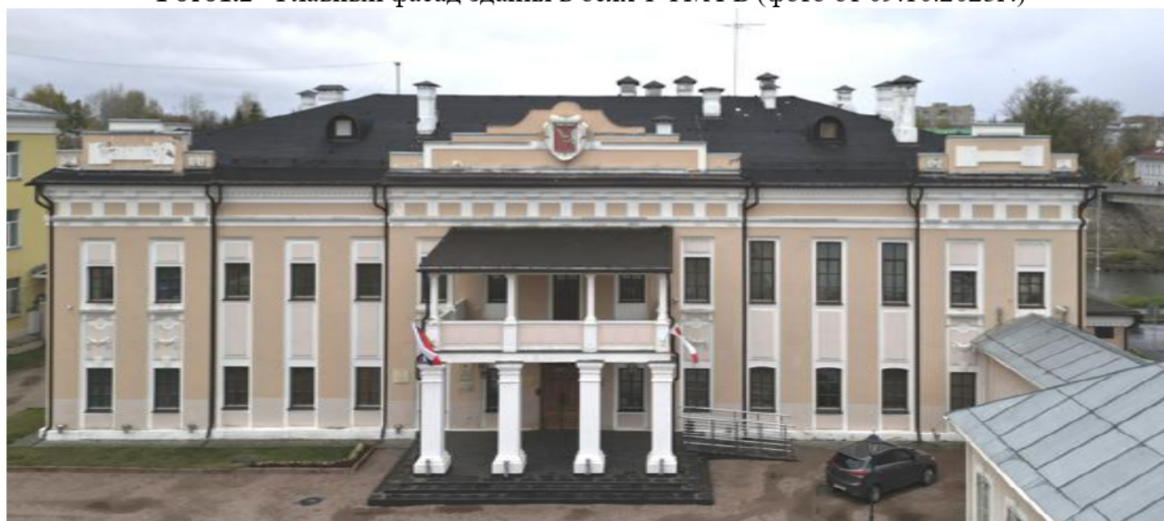
Фото1.3 –Дворовой фасад здания в осях 11-1/Г,Е-Ж (фото от 09.10.2023г.)
