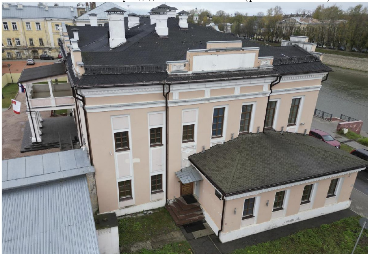
Фото 1.5 – Боковой фасад здания в осях Ж-А/1-3 (фото от 09.10.2023г.)
