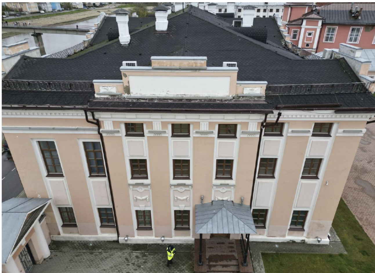
Фото 1.4 – Боковой фасад здания в осях А-Ж/10-11 (фото от 09.10.2023г.)
