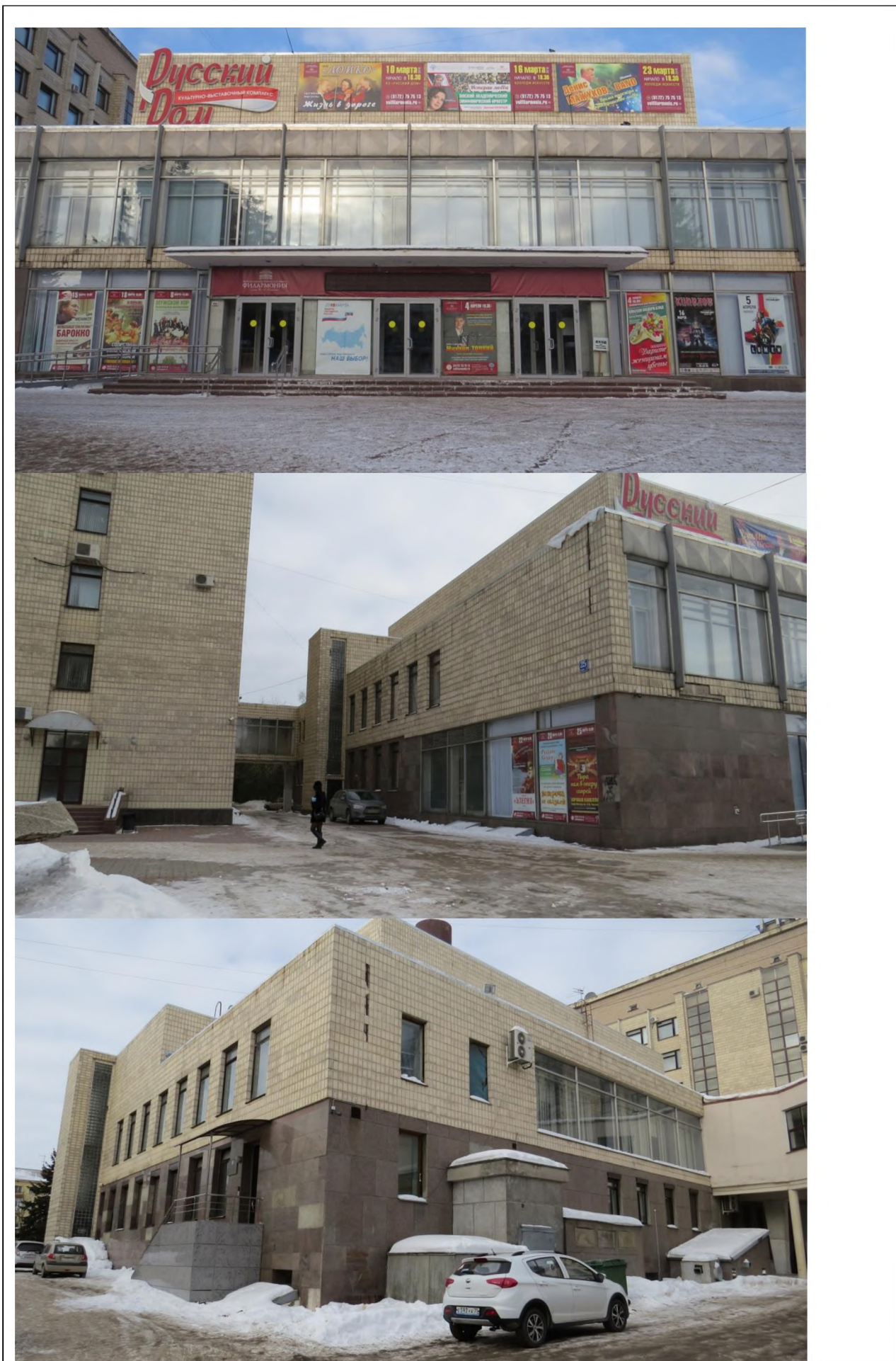
Фотографии фактического состояния фасада с указанием даты (фототаблица)
