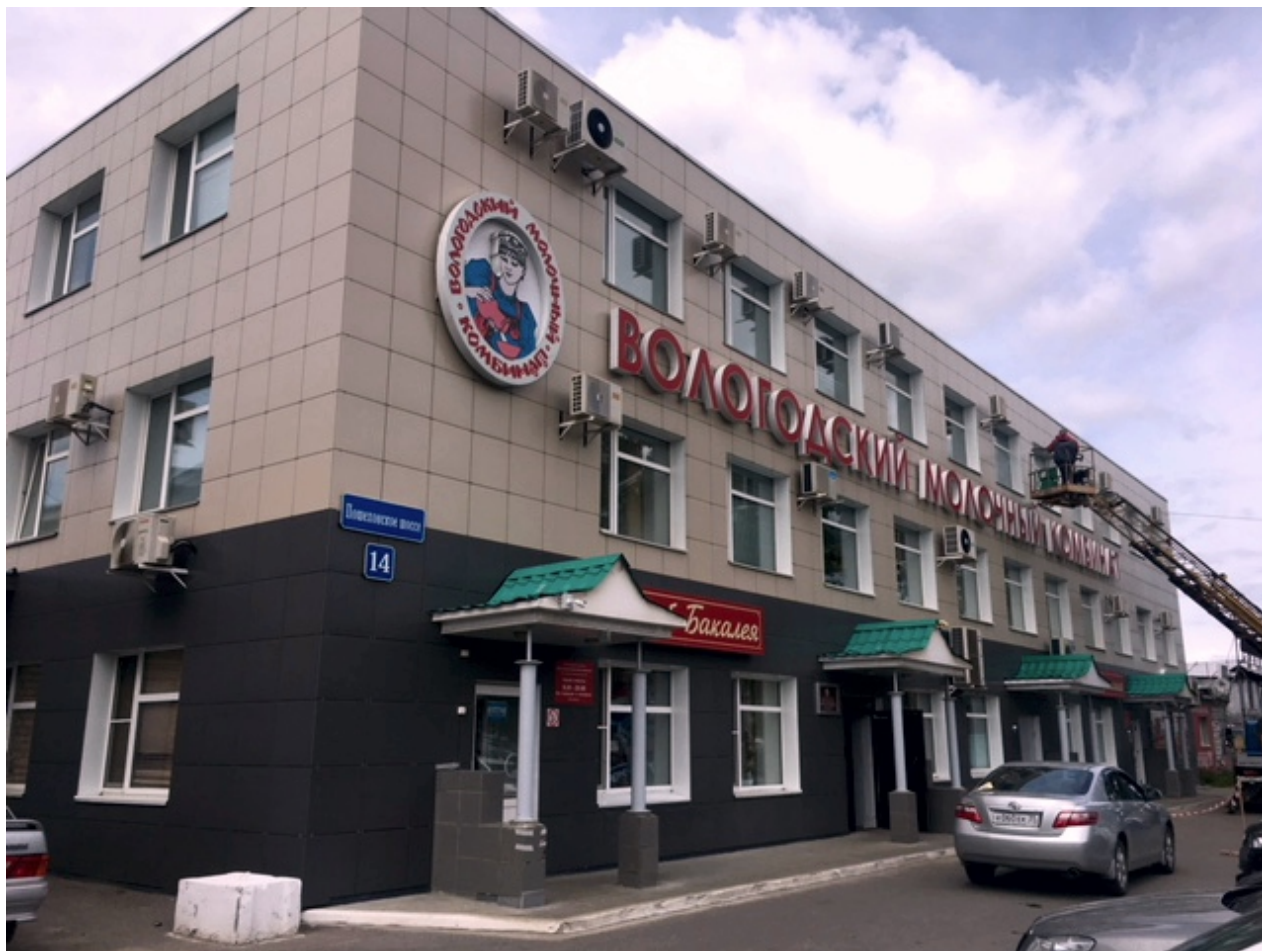
Фотографии фактического состояния фасада (на 08.06.2018 г.)
