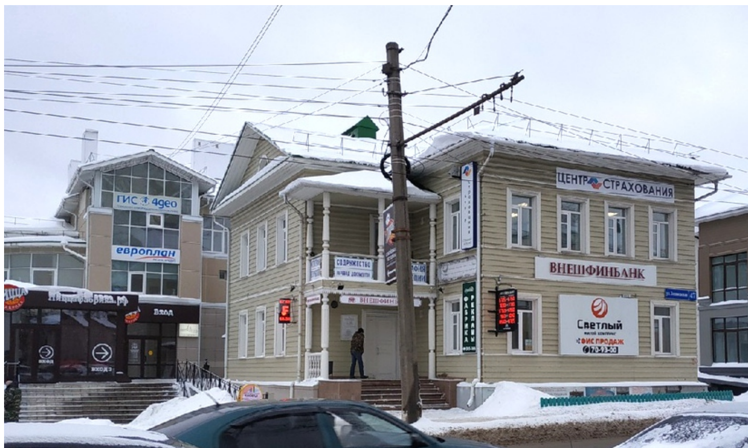
Фотографии фактического состояния фасада с указанием даты (фототаблица)
