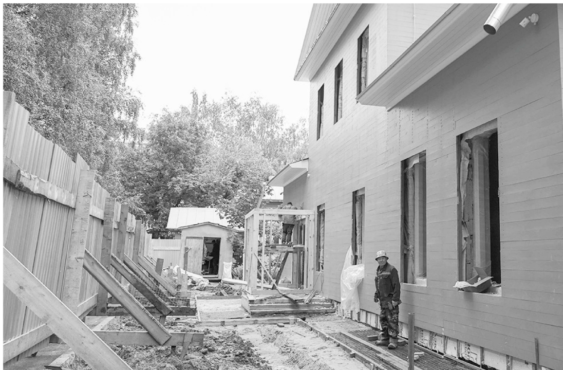
Прохожие уже могут заметить преобразование фасадной части здания и декоративных элементов.
