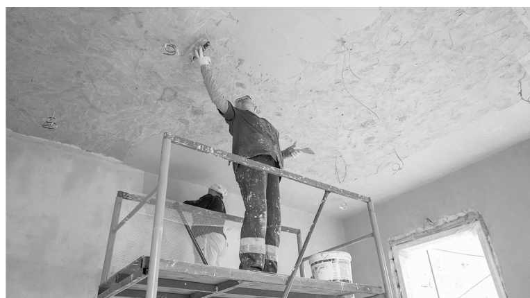
Все внутренние работы проводятся с соблюдением строгих норм по охране объектов культурного наследия.
