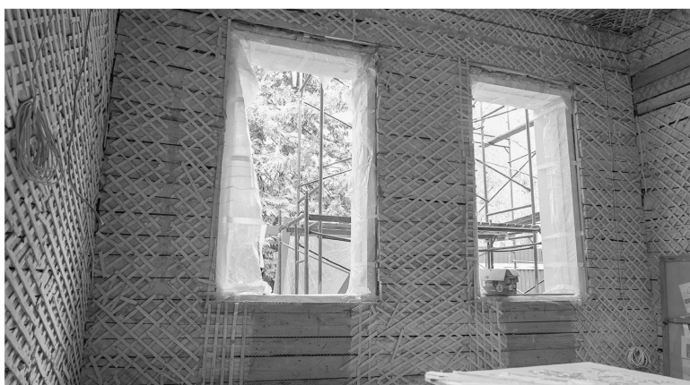
Электропроводка уже разведена по помещениям. В данный момент специалисты сосредоточены на внутренней отделке – оштукатуривании стен.
