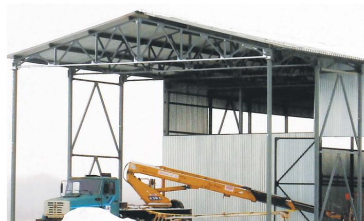
Каркас будущей мусоросортировочной станции уже готов, сейчас рабочие заканчивают обшивку стен.
